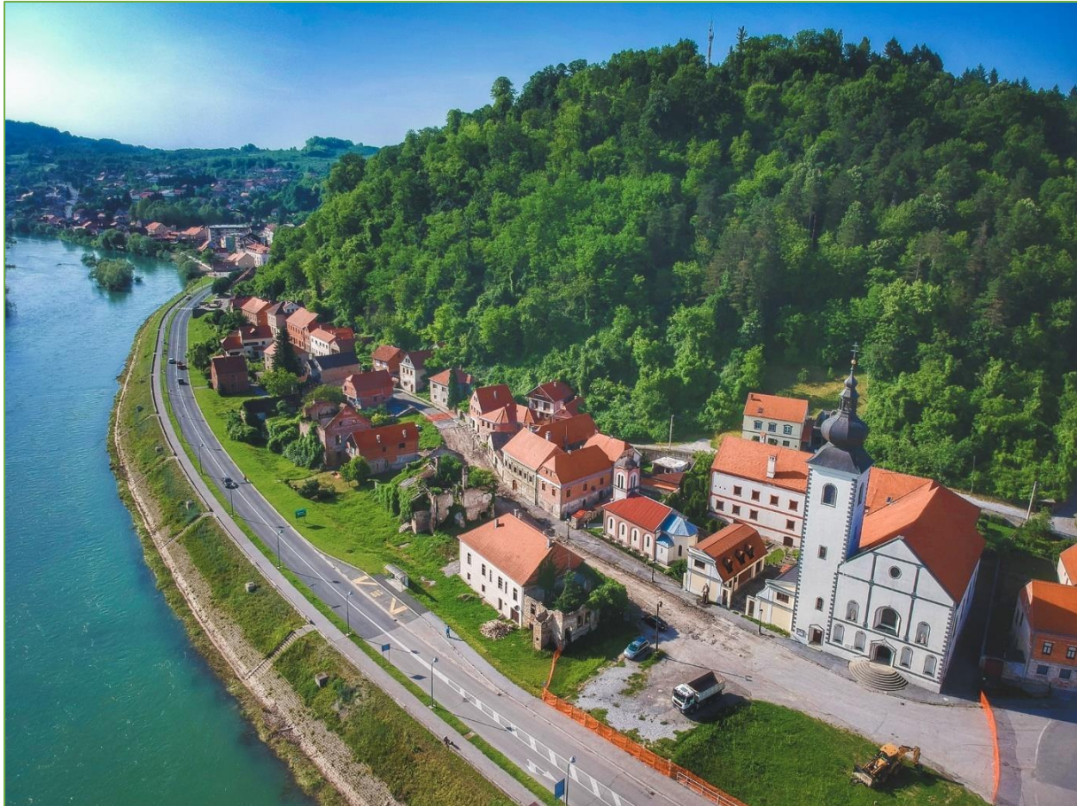
Slika 3. PŠ Brdo Djed u sklopu povijesne jezgre Hrvatske Kostajnice (Izvor: TZ grada Hrvatska Kostajnica, društvena mreža, 2022)
